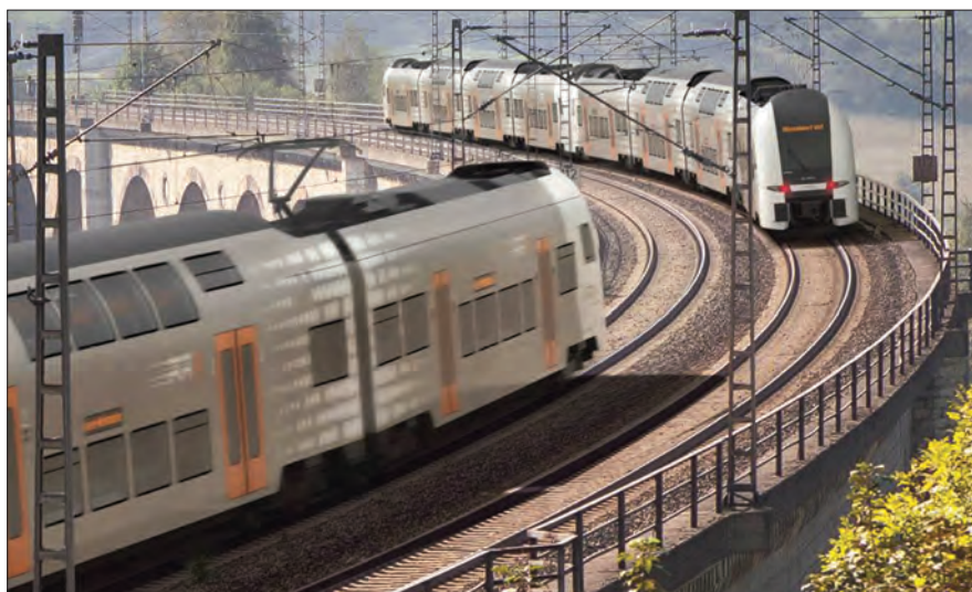
Abb. 1: RRX-Triebwagen auf dem Altenbekener Viadukt (Quelle: www.siemens.com )
